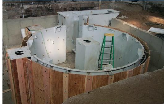
Installation de la coque d'acier en option pour puits de fondations, avec escalier droit. La coque permet de réduire le travail de coffrage sur mesure et les frais d'installation.
